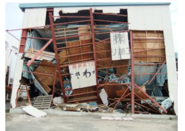
倒壊したままの家屋
