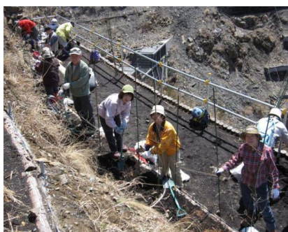
植樹開始 支柱を立てて
